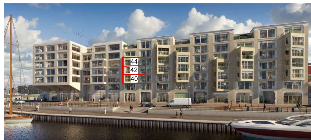
gevelaanzicht bouwdeel ZECC
