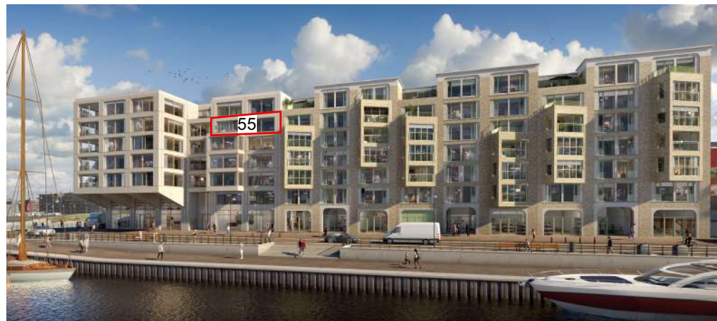
gevelaanzicht bouwdeel LEVS
